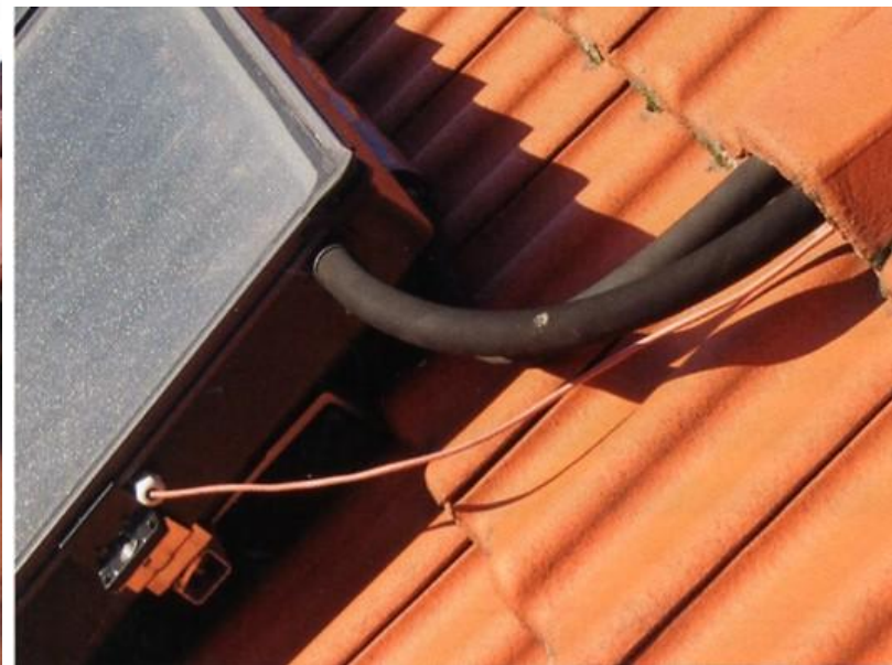
Kabloja e sensorit (sondës) temperaturike jo e përforcuar dhe e pa mbrojtur
