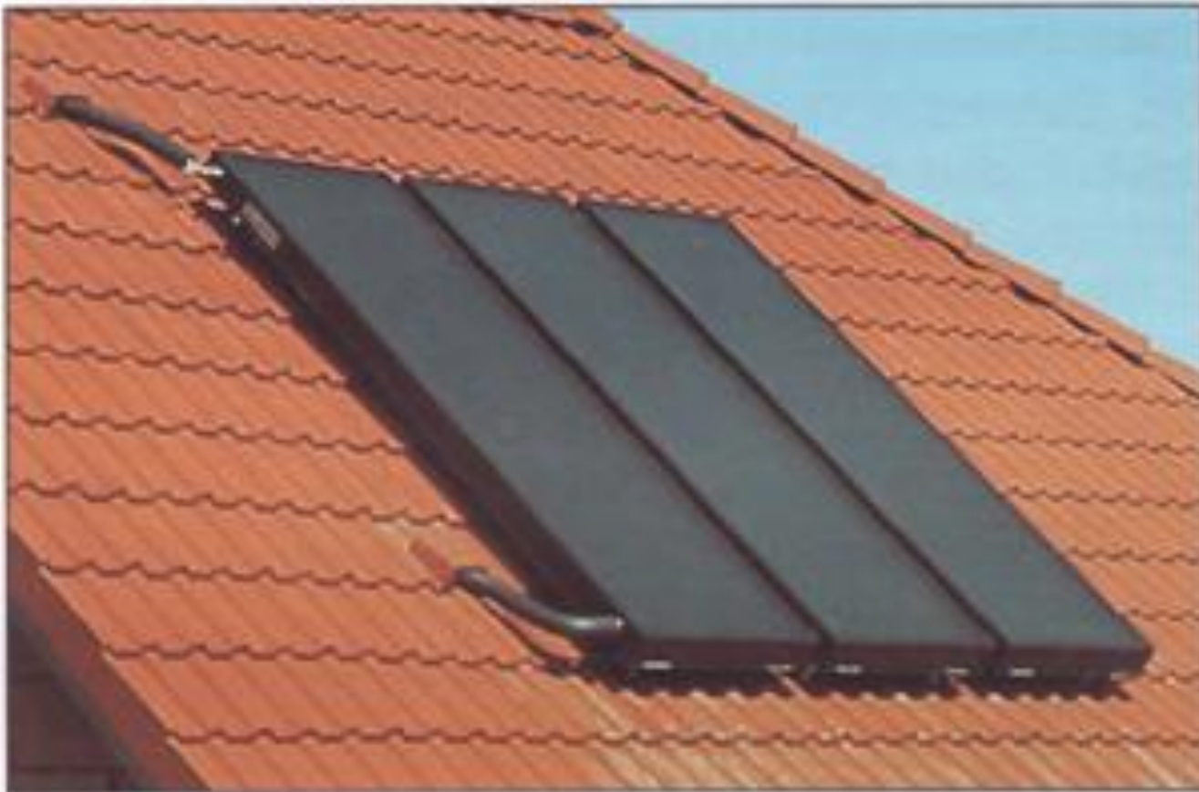
Mënyra e montimit të tubit të dërgimit dhe kthimit të KOLEKTORËVE DIELLORË nën tjegullat e KULMIT
